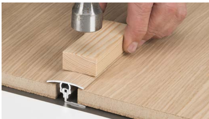
Instalace přechodového profilu hliníkového
